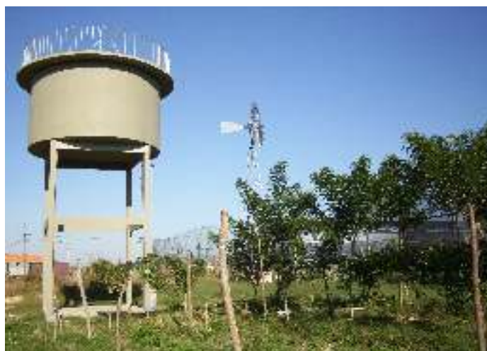
Figura 1: castelo de armazenamento de água e cata-vento.
