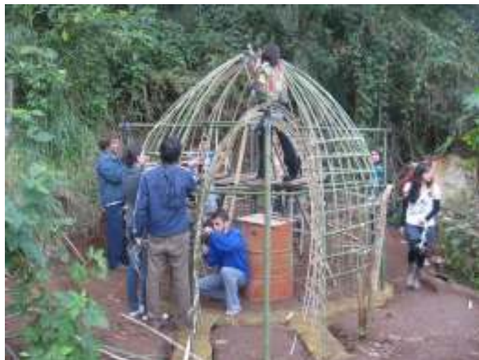
Oficina de Bioconstrução na Semana Acadêmica de Engenharia Florestal
