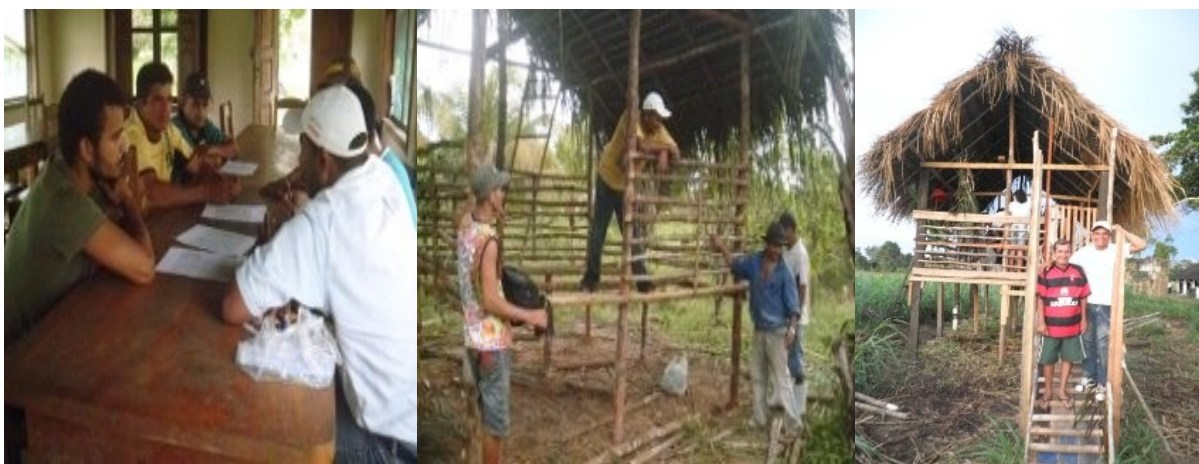
FIGURA 1, 2 e 3 respectivamente: Reunião com os produtores; Construção dos apriscos; Aprisco concluído.
