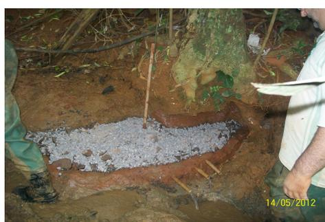
Figura 2: Foto mostrando nascente protegida, antes do selamento com solo cimento.
