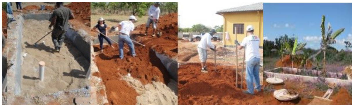
Figura 3– Processo de construção da bacia de evapotranspiração. Fonte:Lima, 2012
