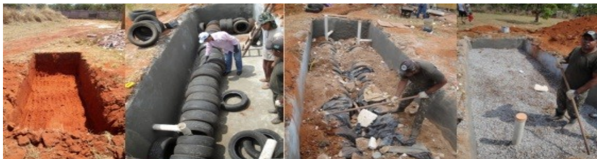
Figura 2 – Processo de construção da bacia de evapotranspiração, Fonte:Lima, 2012
