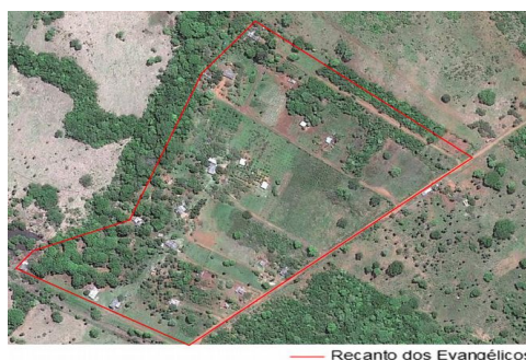
FIGURA 1 – Vista aérea do limite do Recanto dos Evangélicos, onde reside a maioria dos moradores da Comunidade de Antonio Maria Coelho (AMC).
