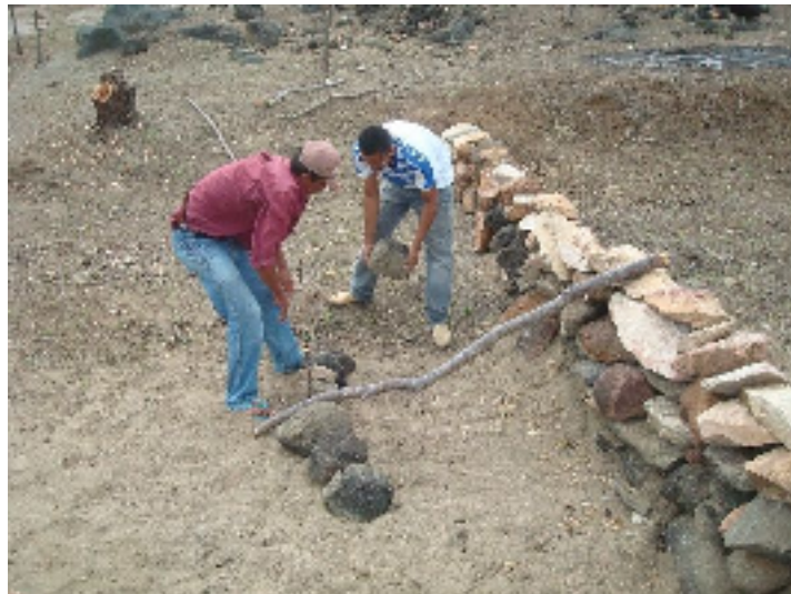
FIGURA 2. Estagiário e agricultor construindo barramento de pedras para controle da erosão.
