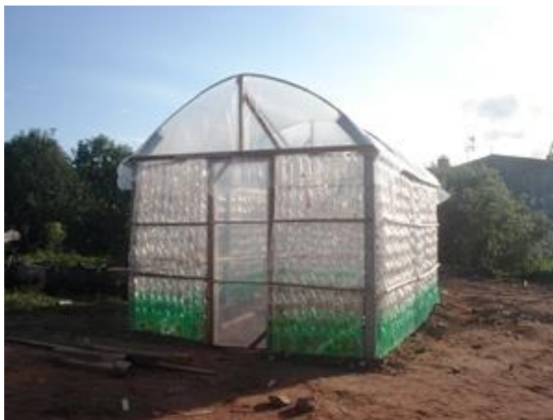
Foto 2: Construção da estufa finalizada.
