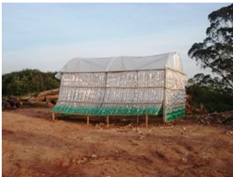
Foto 3: Abertura lateral das cortinas de pet.
