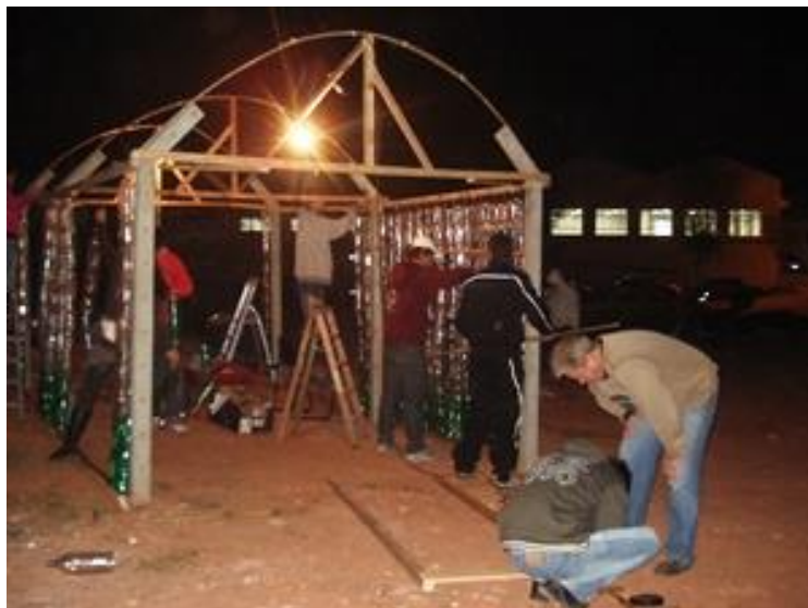
Foto 1: Estruturação das paredes da estufa com as linhas de garrafas pet.
