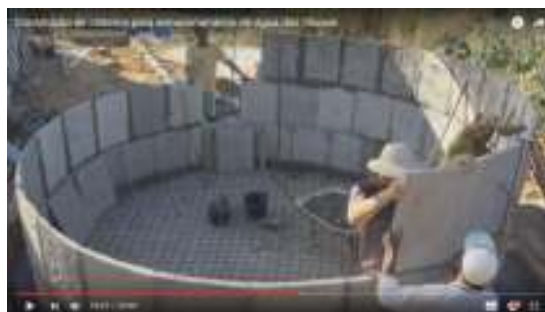
Figura 3: Construção de Cisterna para armazenamento de água das chuvas Fonte:
