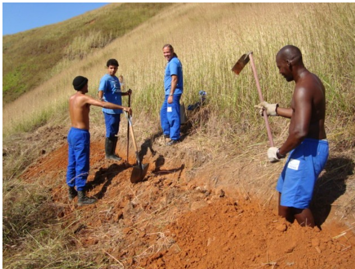
FIGURA 2. Internos trabalhando na abertura de valas em curvas em nível para minimizar os efeitos da erosão.
