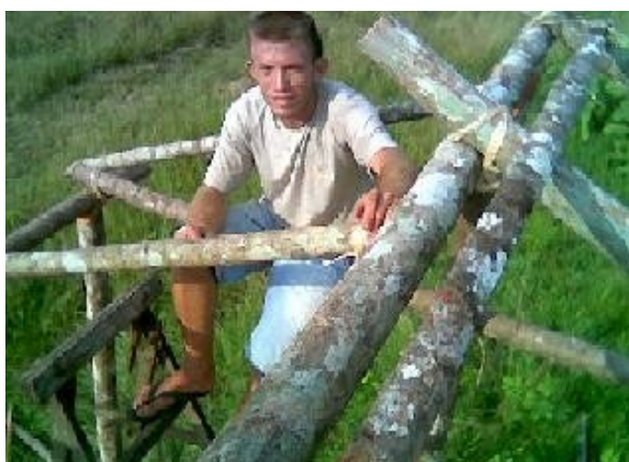
Figura 1: Montagem e Amarração dos estipes.
